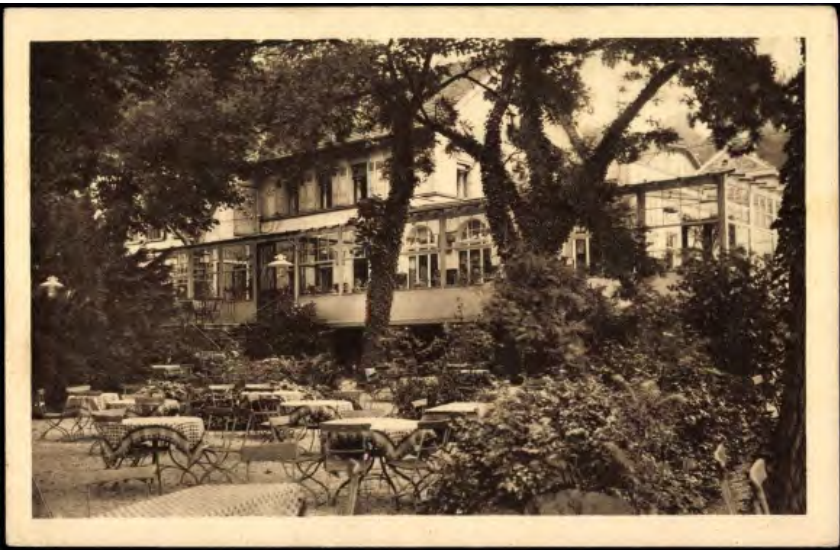
Ziegelhausen Heidelberg am Neckar
